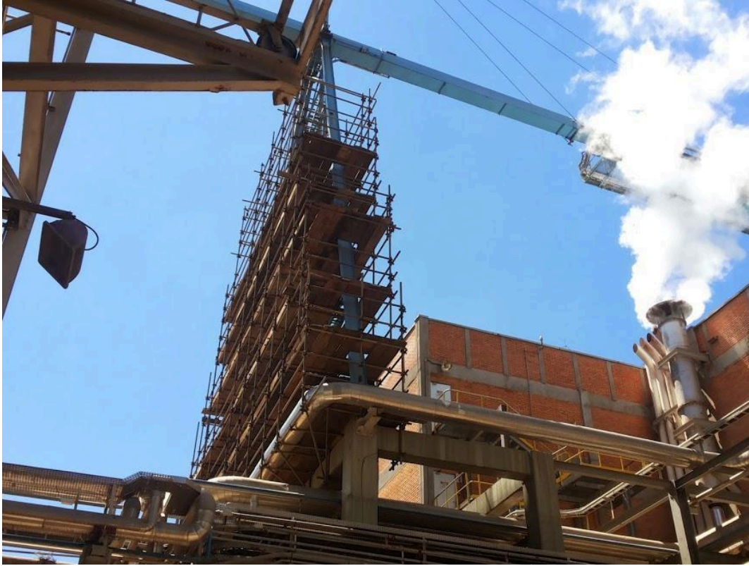
- Foto 10 (Obra: Montagem de Andaime - Rigesa – Duto de cavaco).
