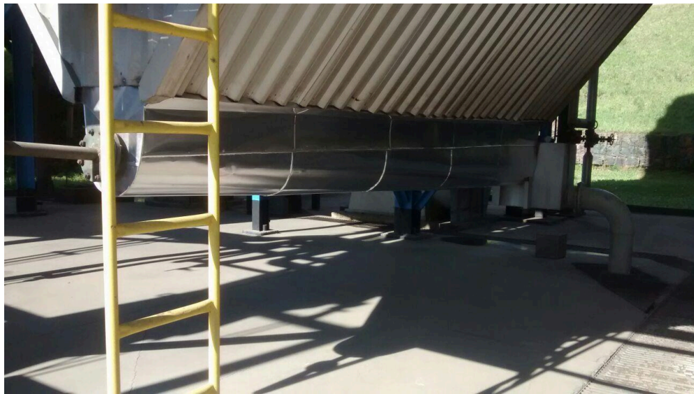
- Fotos 04 e 05 (Obra: Isolamento Térmico – Celulose Irani S/A).
