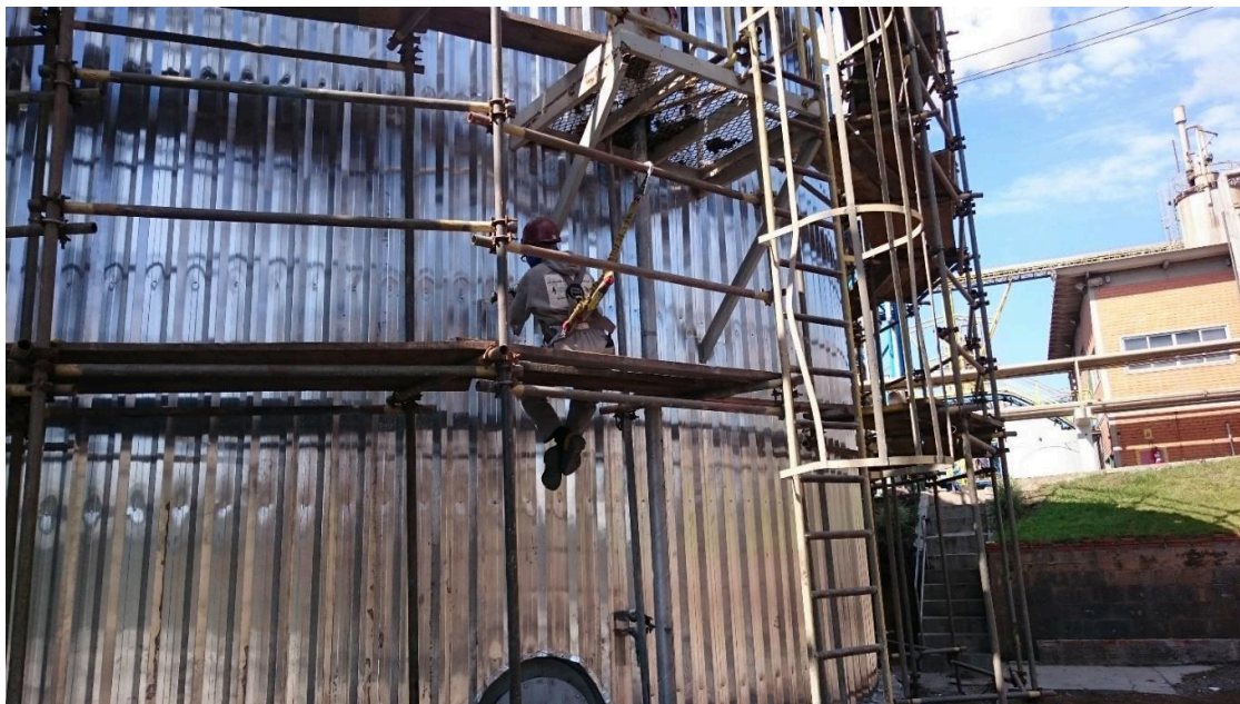
- Foto 01 (Obra: Isolamento Térmico – Celulose Irani S/A).
