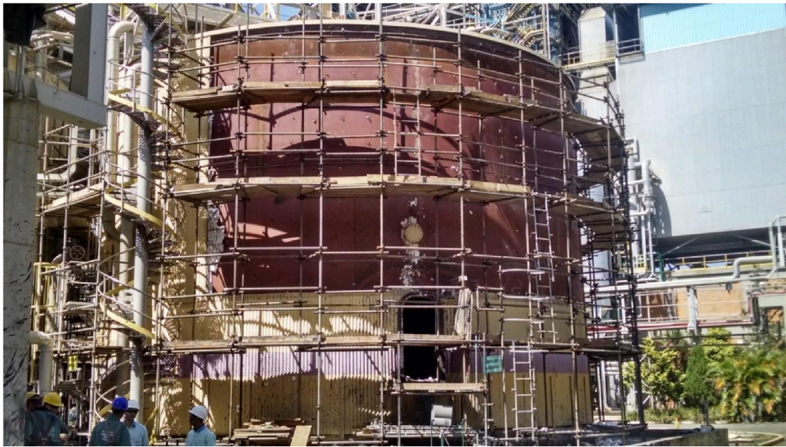
- Foto 03 (Obra: Montagem de Andaime – Rigesa).
