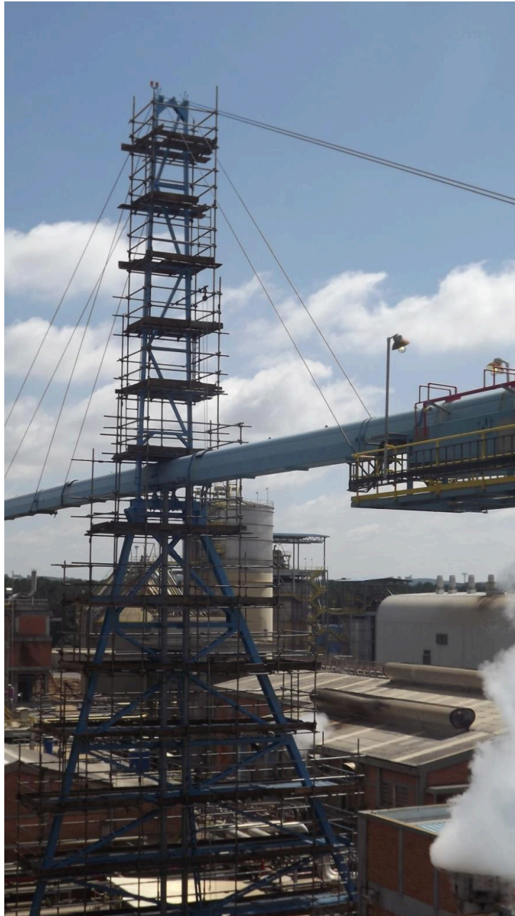
- Foto 09 (Obra: Montagem de Andaime - Rigesa – Duto de cavaco).
